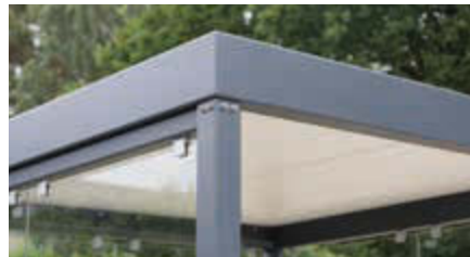
▲ Detail: Stützenverbindung mittel Edelstahlschrauben
