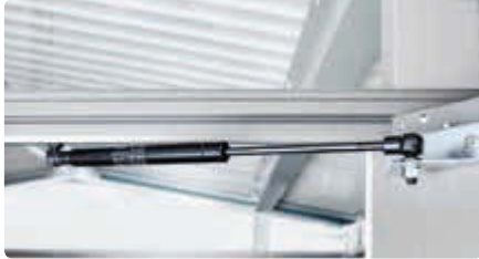
▲ Detail: Gasdruckfeder
