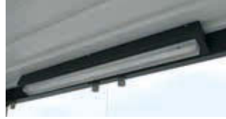
▲ Ein- / Aufbauwannenleuchte mit Leuchtstoffröhre und Lampenkasten aus Stahlblech
