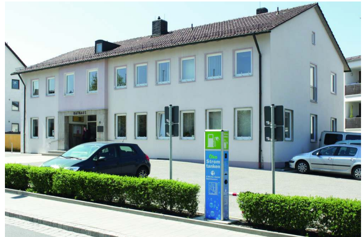
Stromtankstelle COLOM mit Werbeaufsatz und Folienbeklebung
