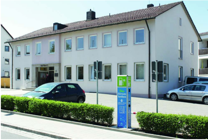
Stromtankstelle COLOM mit Werbeaufsatz und Folienbeklebung
