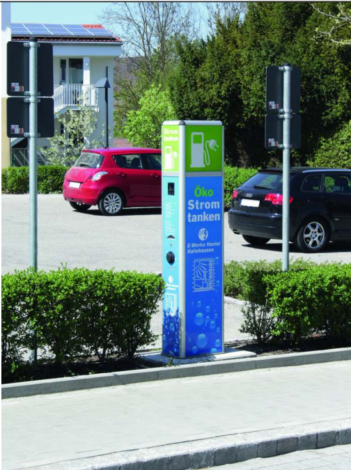
Stromtankstelle COLOM mit Werbeaufsatz und Folienbeklebung
