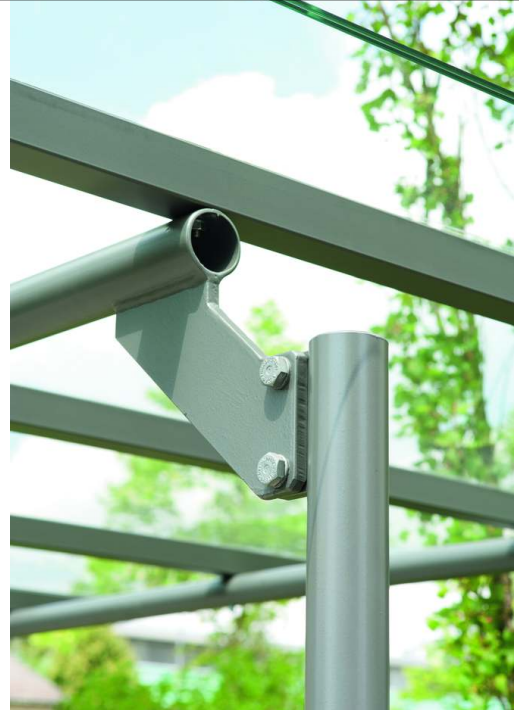
Detail: Stützenkopf
